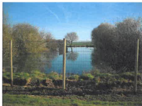
Réserve à incendie de 4 700 m3
